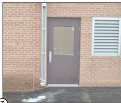
⑦ HOLLOW METAL DOOR & HOLLOW METAL FRAME
